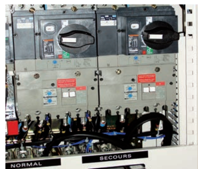
Disjoncteur "normal" et "secours"
