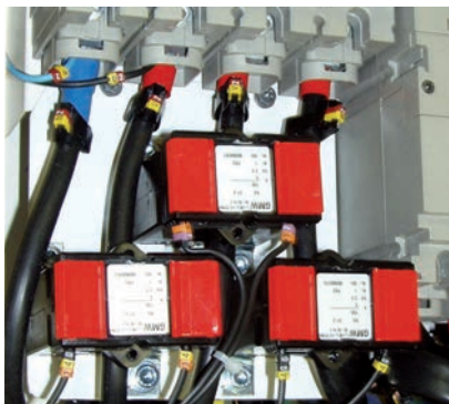
Transformateur d'intensité
