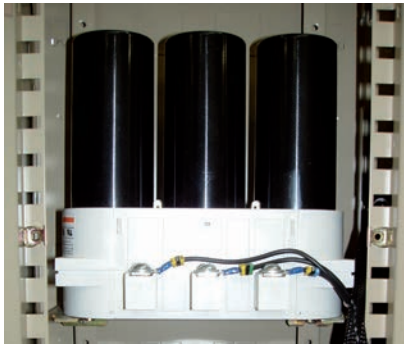
Batterie de 3 condensateurs
